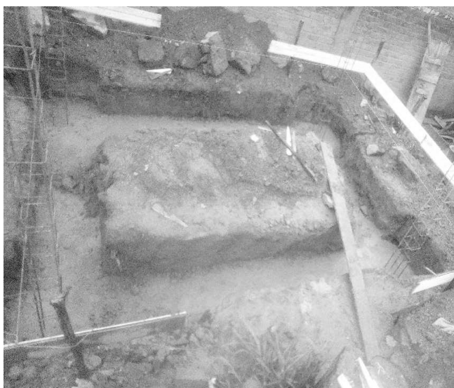
Fondations de la cuisine
