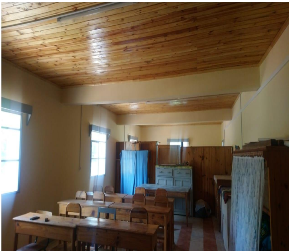
Salle de cours des novices après rénovation
