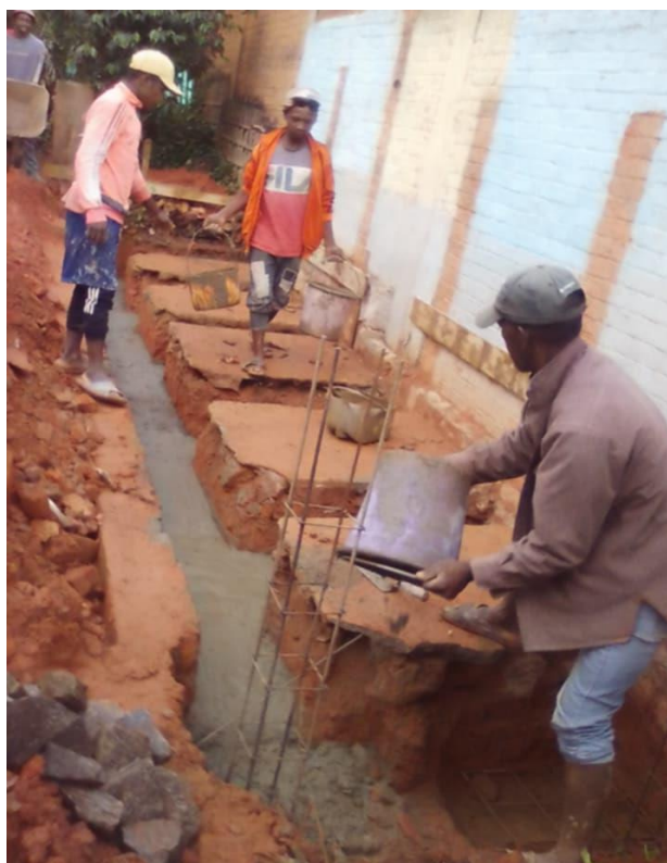
Fondations du futur bloc sanitaire
