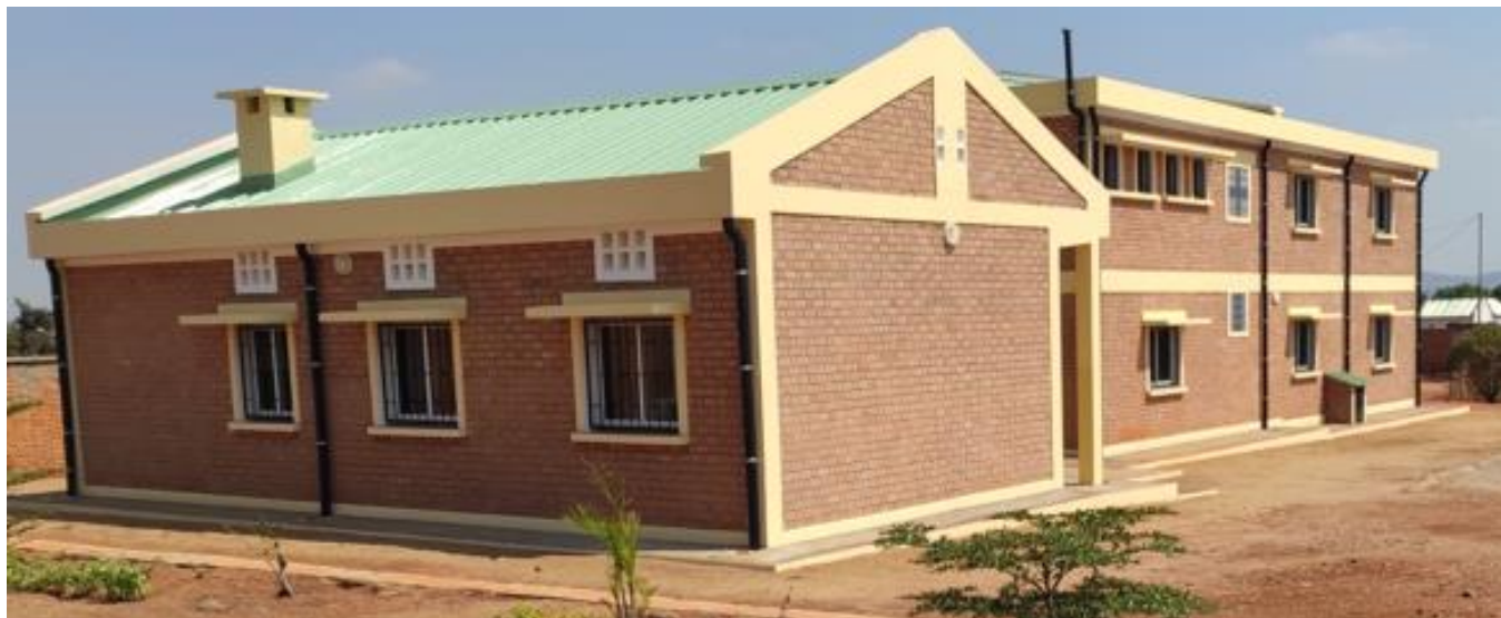
Vue de l'annexe dans laquelle se trouvent le réfectoire, la cuisine et les sanitaires
