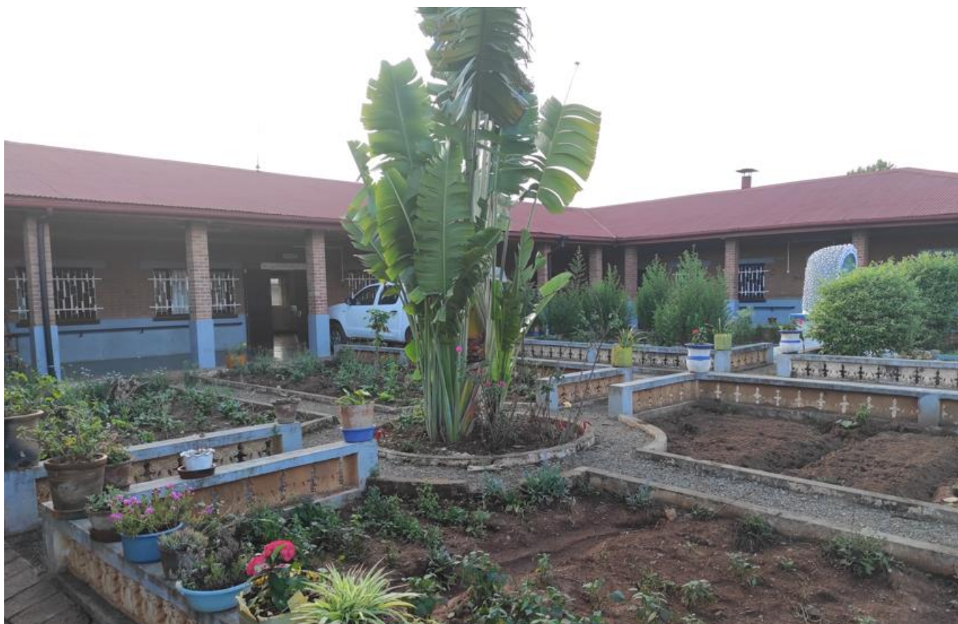
Il y a 5 ans nous leur avons rénové la toiture toute rouillée ... bravo Liva pour le beau travail : la peinture a très bien tenu
