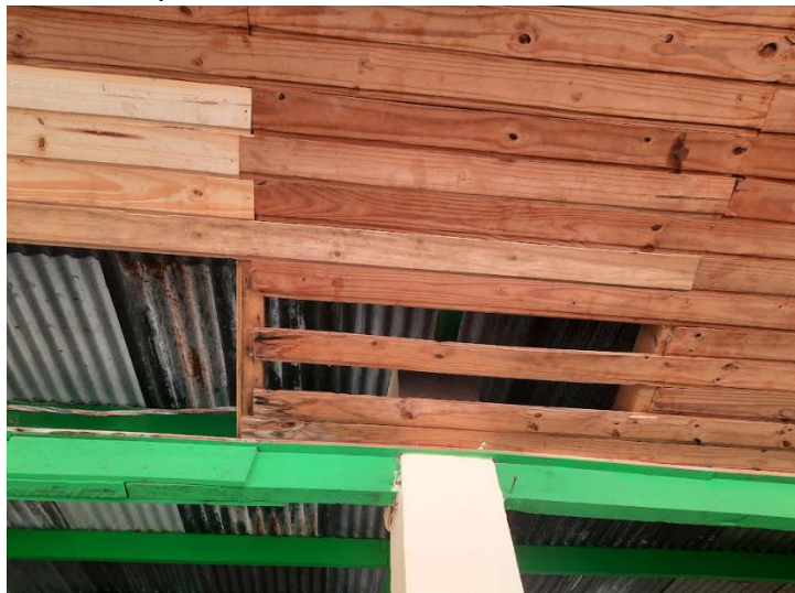
Remplacement de lambris abimés
