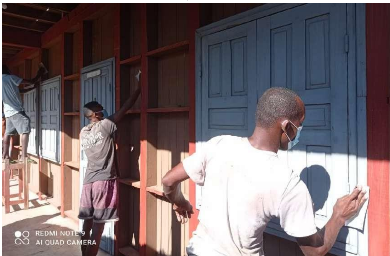
Lessivage et ponçage des boiseries extérieures
